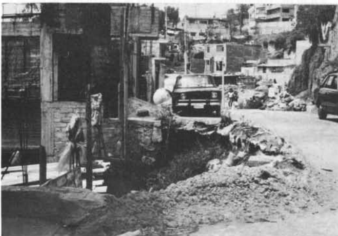
Figura 5.- La cabecera de un barranco menor avanza sobre una calle.
