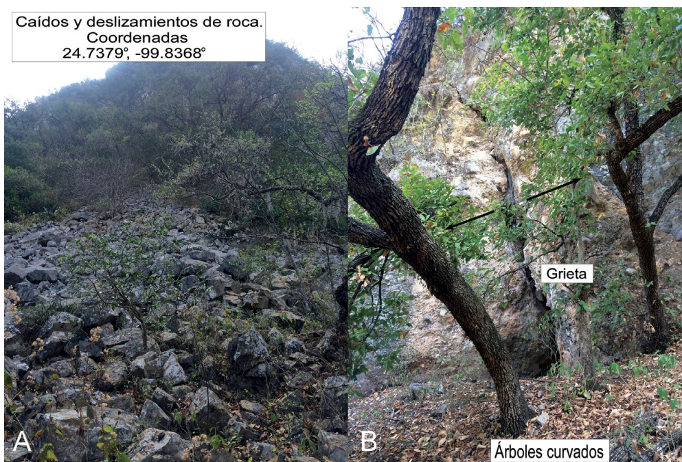
Figura 9. (a) Indicios de reactivación de paleomovimientos en masa debido a la sobrecarga por depósitos recientes (a) y evidenciada por la presencia de grietas de tensión y la presencia de árboles curvados en favor de la pendiente (b). Desencadenante desconocido.
