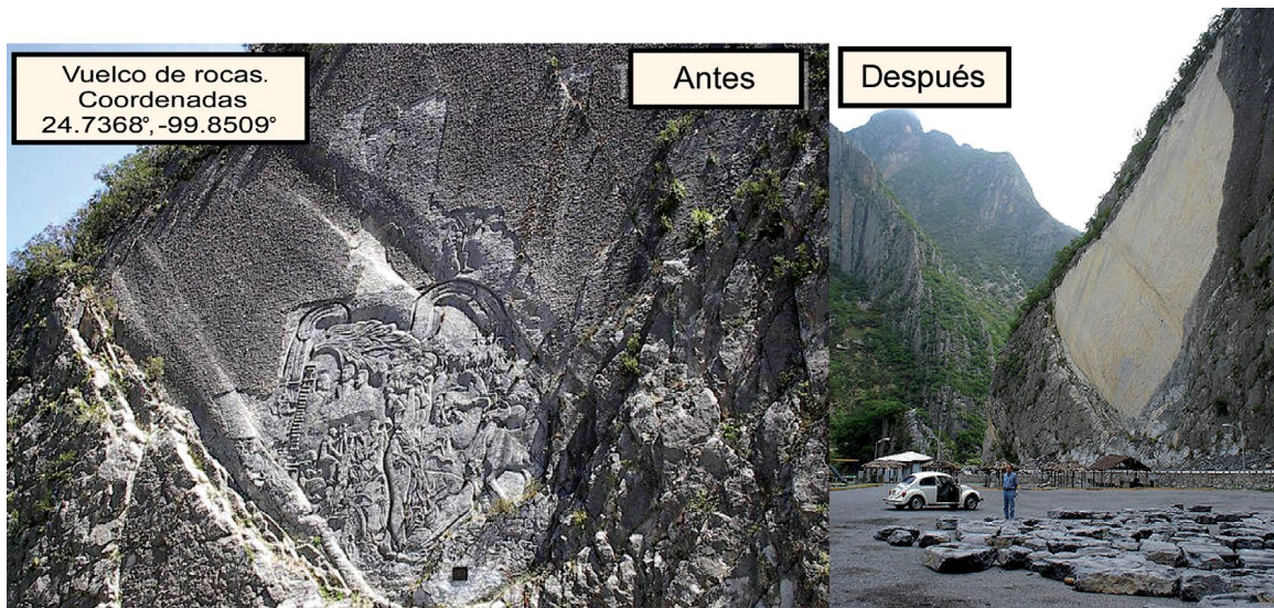
Figura 4. Movimiento en masa en "Los Altares". El mural tallado en piedra ("Antes", imagen tomada del blog http://tierraregia.com/mi-ciudad/mi-ciudad-mi-historia-iturbide-n-l , acceso 3 Enero 2017) colapsó en Junio del 2002 debido a lluvias torrenciales, originando bloqueo del tramo carretero y destruyendo parcialmente el paraje turístico provisto para esparcimiento familiar ("Después", imagen tomada del blog http://www.flickr.com/photos/cadeva/41919996/ , acceso 3 Enero 2017).
